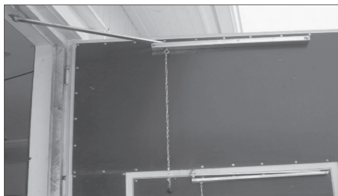
Järeä tuulisalpa 004 asennettuna hallin oveen, ja tuulisalpa 001 käyntioveen asennettuna.
